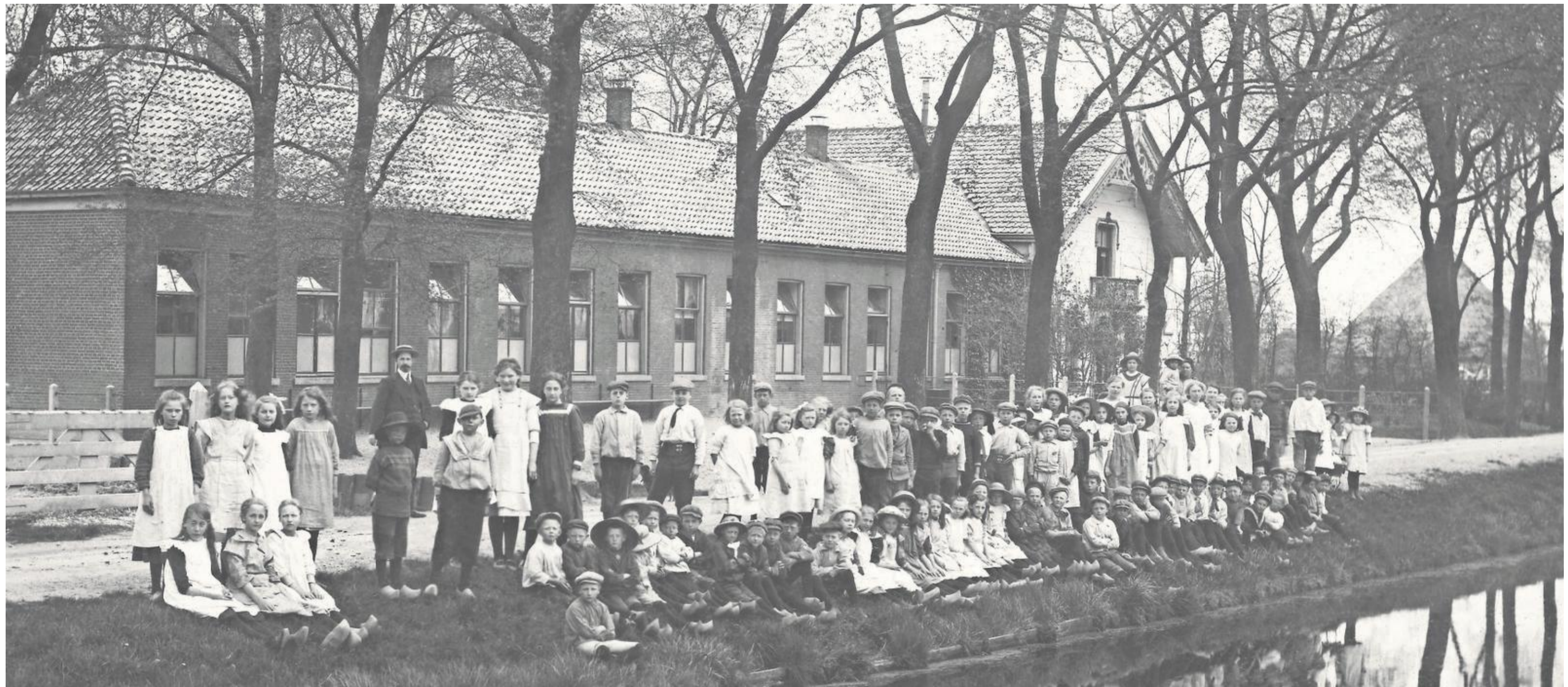
Ruim honderd leerlingen van de openbare lagere school in Wieringerwaard, ruim een eeuw geleden. Rechts de onderwijzerswoning. De Medemblikker architect Arnoldus Teunis van Wijngaarden (1819-1900) vergrote en verbouwde het complex in 1871.
